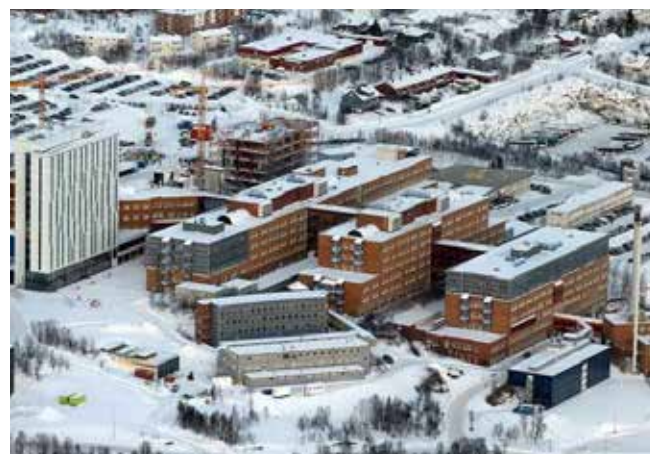
UNN, Tromsø ligger nord på Tromsøya i tilslutning til UiT. Litt til venstre i bildet er det nye pasienthotellet og bak til høyre det nye PET senteret. Foto Ronald Johansen
